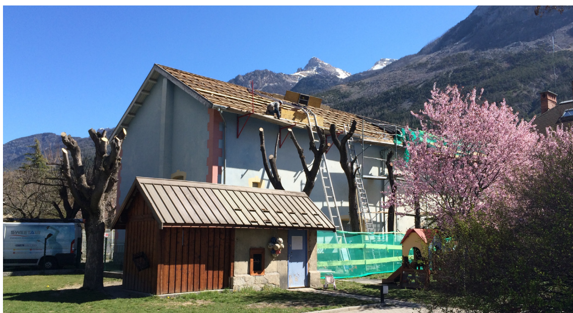
Centrale photovoltaïque n° 12 – Montage sur toiture du cinéma "L'Eau Vive" à L'Argentière la Bessée
