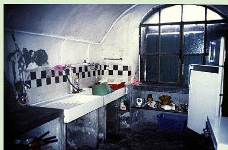
La cuisine avant les travaux...
