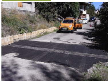
Réfection « piège à eau » route des moulins au Villaret.
