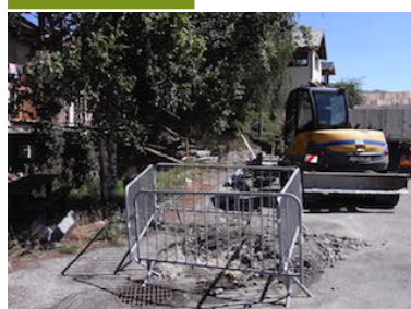
Préparation chantier pour pose conduite d'eau pluviale sous la place Violin au chef-lieu.
