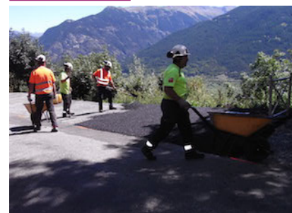
Goudronnage devant la Mairie, pour faciliter le stationnement, avec en particulier une place réservée pour voiture PMR.
