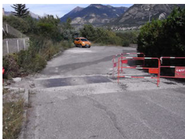
Réfection « piège à eau » en bas de la route du Clos du Vas.
