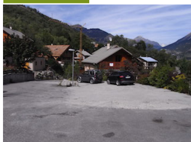
Dans le quartier de Champ Guy, regoudronnage de la zone haute de retournement des véhicules.
