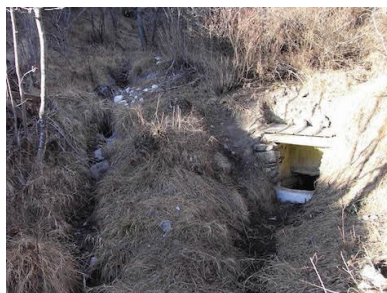
Remise en état de la source de Puy Chalvin, qui alimente la fontaine de Puy Chalvin et le torrent du four réalisés par Davy et Gregory
