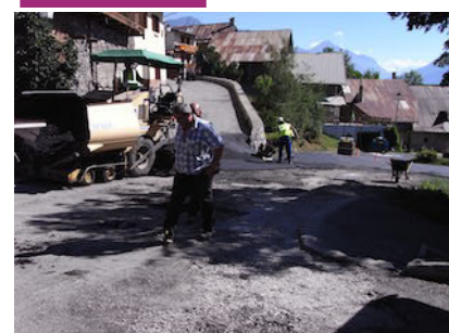
Réfection chaussée sous la kimpina, avec réfection « piège à eau ».
