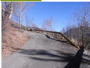
Barrière de sécurité en bas de la rue du four à Pierrefeu : installée par l'entreprise QUEYRAS TP.
