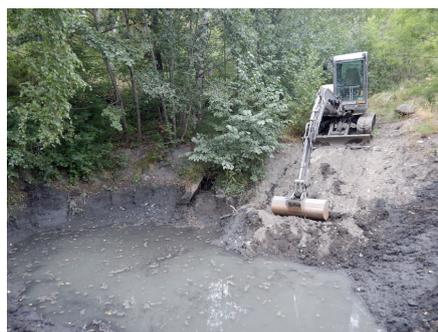
Curage du bac de rétention d'eau à Pierre Feu - qui a permis de limiter les dégâts des fortes pluies
