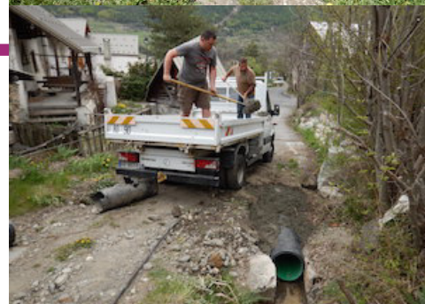
Réembusage d'une partie du canal à Pierrefeu
