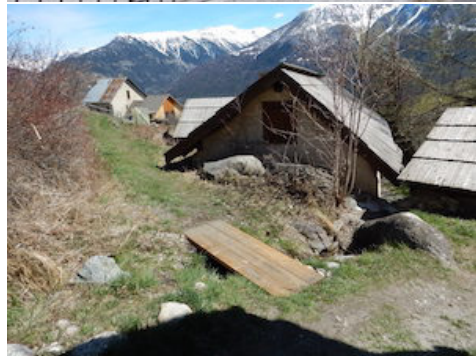
Création d'une passerelle à Puy Chalvin
