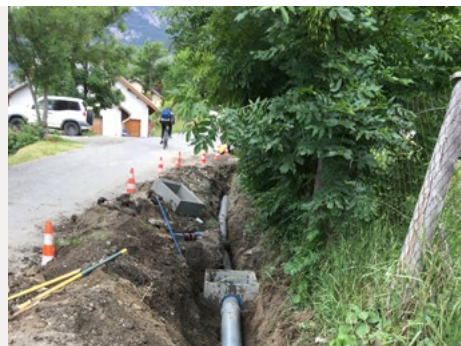
Embusage du canal à Pierrefeu
