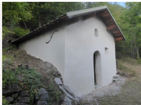
Chapelle St Jean Baptiste du Goutaud dont les enduits extérieurs ont été refaits.
