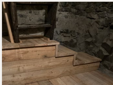
Plancher de l'église
