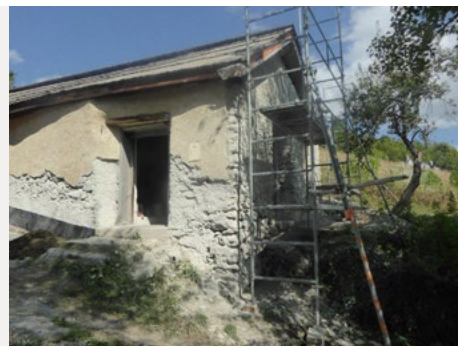
Four de Puy Chalvin pendant les travaux de restauration et de drainage
