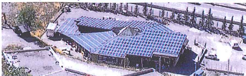
Toiture photovoltaïque de la Ressourcerie La Miraille à Saint Martin.
